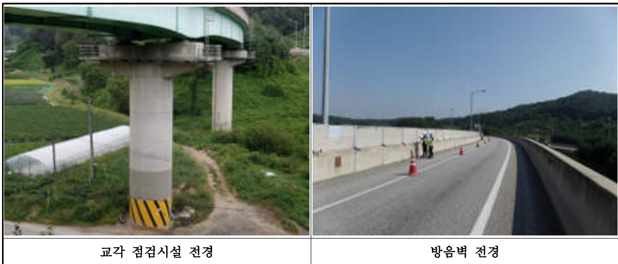
【그림 3-11】 충주IC1교 기타 부대시설 전경(점검시설, 방음벽)
