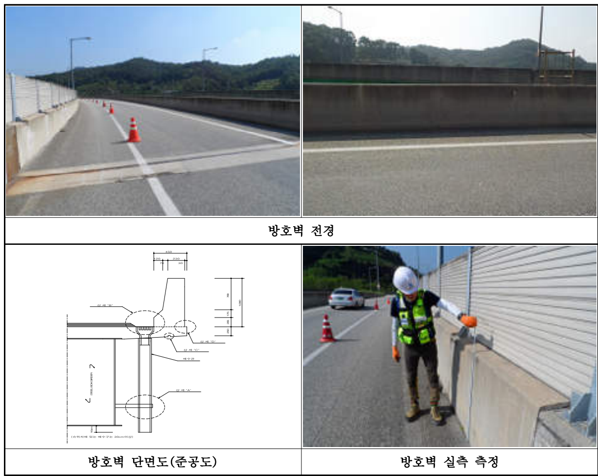
【그림 3-10】 충주IC1교 방호벽 전경 및 단면도
