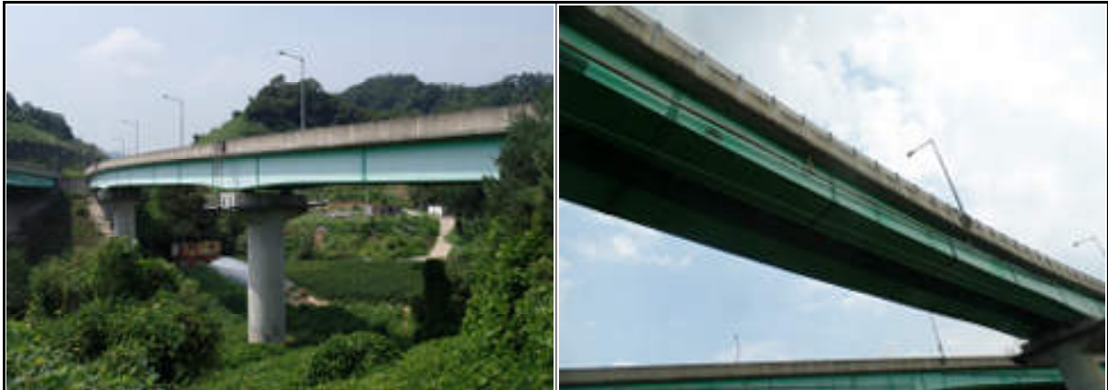
Steel Box Girder 외부 전경
